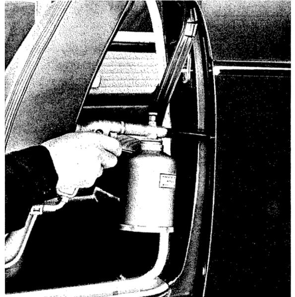
7 - Die Innenflächen in den vorderen, unteren Bereichen der Hohlräume werden mit einer normalen Sprühpistole durch die Spalte zwischen den Kotflügeln und Seitenteilen vom Radhaus und von den Kotflügelunterkanten her behandelt.
