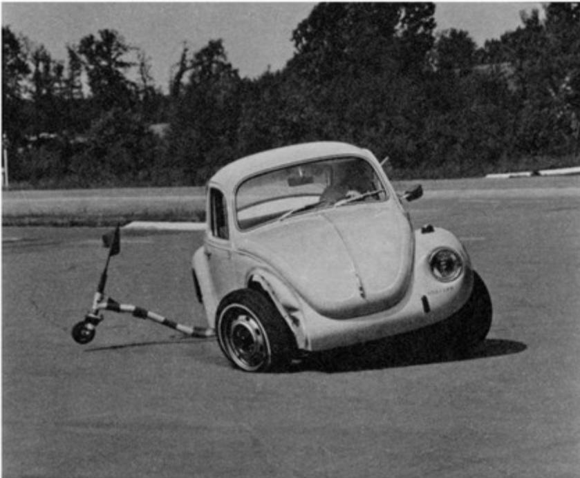
*Die Apparatur, die dem auf der Kreisbahn verkehrenden 411 die ungewöhnliche Anzahl von insgesamt 14 Rädern beschert (links und oben), ist in der Lage, die bei verschiedenen Geschwindigkeiten auftretenden Schräglaufwinkel und — mit dem Heck-Anhängsel — den Schwimmwinkel des ganzen Autos zu registrieren. Der mit einem Ausleger versehene Käfer absolviert Reifenprüfungen mit Luftdrücken, die 0,3 bis 0,4 atü unter dem in der Betriebsanleitung empfohlenen Wert liegen.*
