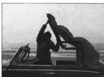
**1** In geöffnetem Zustand wird das Verdeck des Käfers unter einer voluminösen Haube versteckt. Mit Druckknöpfen gesichert, ist sie schnell gelöst und gibt die leicht zu klappende Ziehharmonika frei
